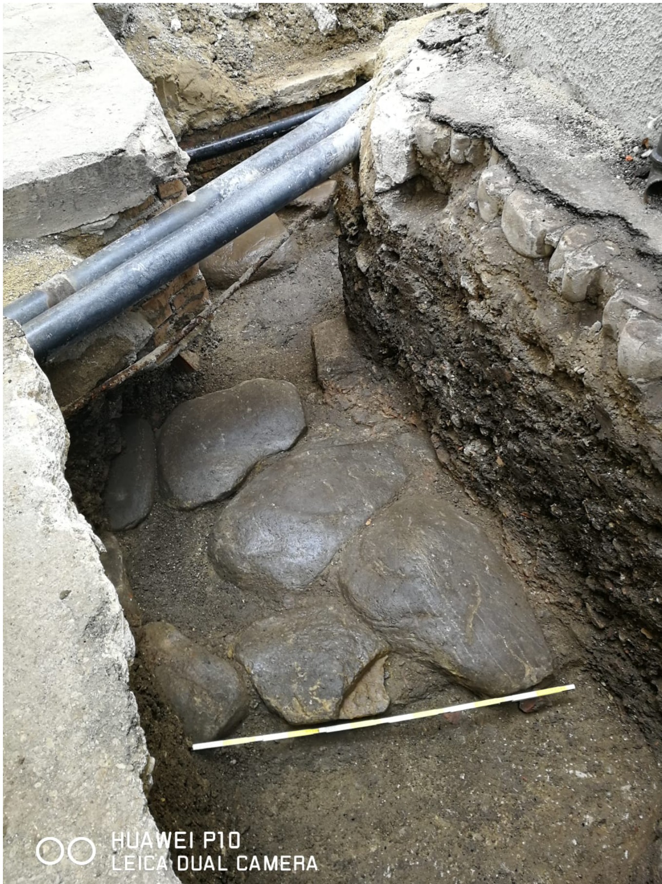
In questi giorni a Teramo, in via Pretuzio angolo Vico dello Zoppo, è stato rinvenuto un tratto di basolato stradale della Città romana di Interamnina Praetut(t)iorum. Si tratta dei resti di del decumano minore, con basoli e crepidine, a nord della "domus del Leone" e di "Largo S. Anna" con le strutture successive
